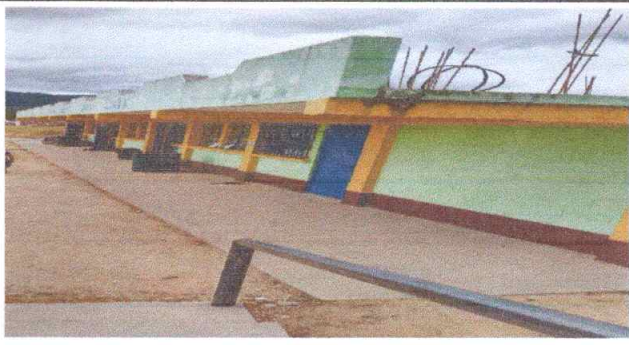
Foto 4: Reparación de planchas de concreto de patio
