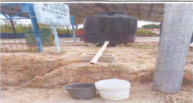
Foto 5: Sustrucción de deposito de agua
