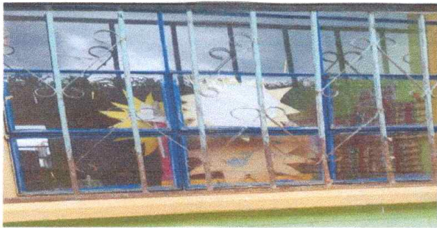
Foto 1: Sustrucción de balcones de metal
