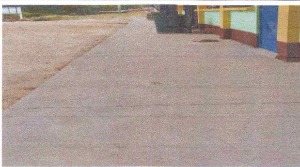
Foto 3: Reparación de planchas de concreto de patio
