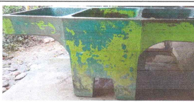
Foto 6: Sustrucción de pila
