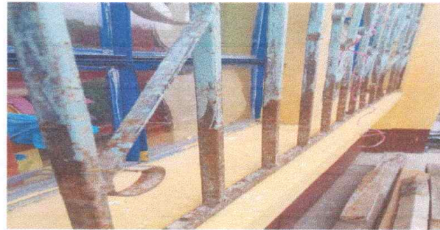
Foto 2: Sustrucción de balcones de metal
